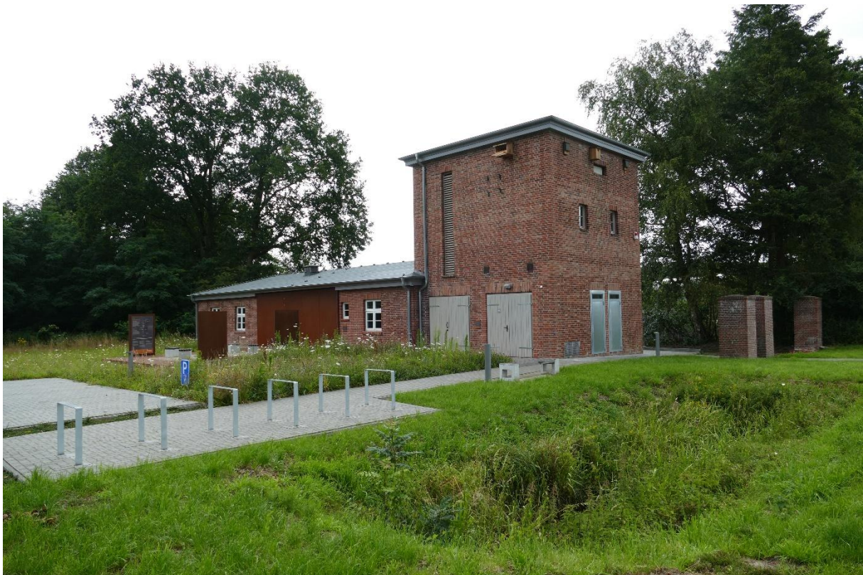
Abbildung 8: Foto zur sanierten Trafostation des Emslandlagers XII (Dalum) in Geeste-Dalum
