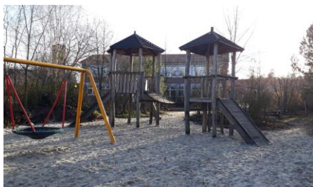
Antoniusschule: Fallschutzflächen nachgearbeitet
