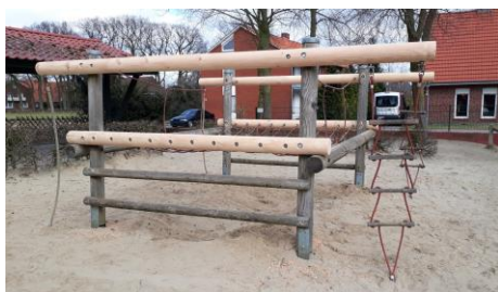
Ludgerischule: Klettergerüst 2018 repariert
