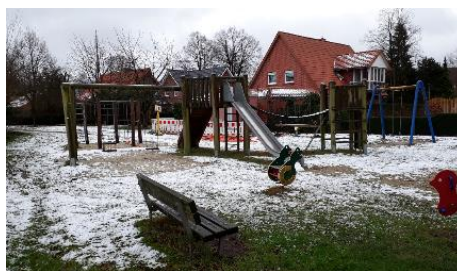
Freskenhof: fehlende Fallschutzflächen
